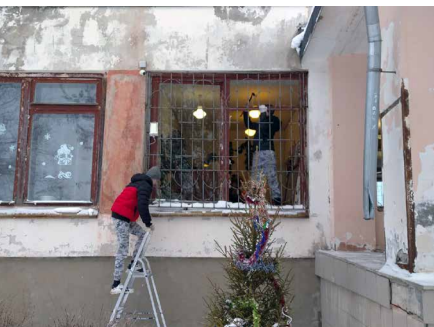
Замена оконных блоков
