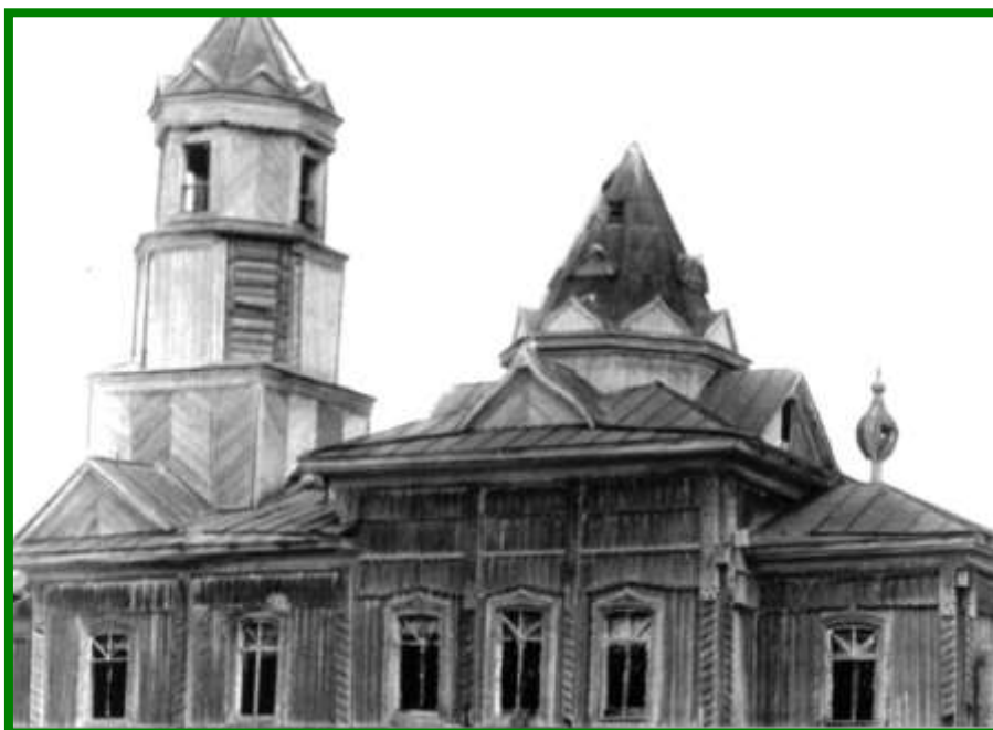
Кувакушская старообрядческая церковь. Южный фасад. Фото 1986 г.
